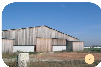
Insertion paysagère réalisée par l'utilisation du bardage bois.
