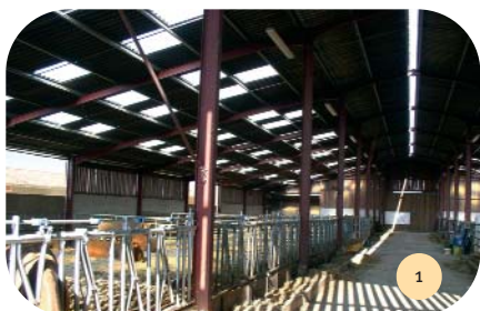
Vue intérieure du bâtiment.
