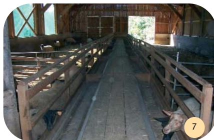
Le couloir d'alimentation central.
