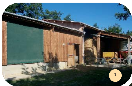
Vue des trois zones du bâtiment : bergerie, stockage fourrages, appentis.
