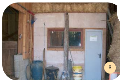
Local technique situé entre la bergerie et le stockage.
