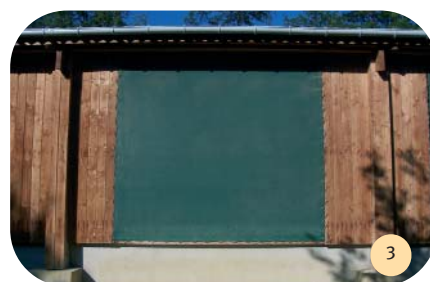
Bardage bois et filet brise-vent.
