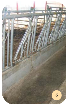
Auge "en creux" ( l = 0,90\text{ m} - H = 0,20\text{ m} ) évitant de repousser l'alimentation.
