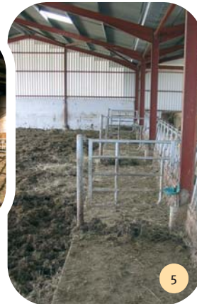
Séparations sur la stalle d'alimentation au niveau de chaque travée.
