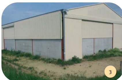
Vue extérieure du bâtiment.
