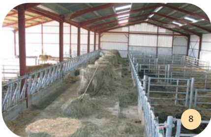
Vue de la répartition des balles de fourrage sur le couloir central.
