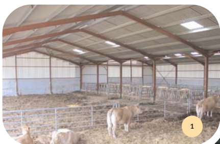
Vue intérieure du bâtiment.
