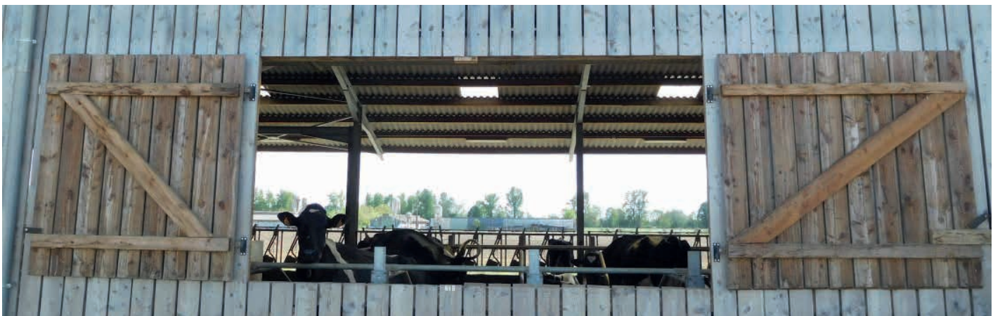
Photo 13 volets bois (Crédit photo : Btpl)
