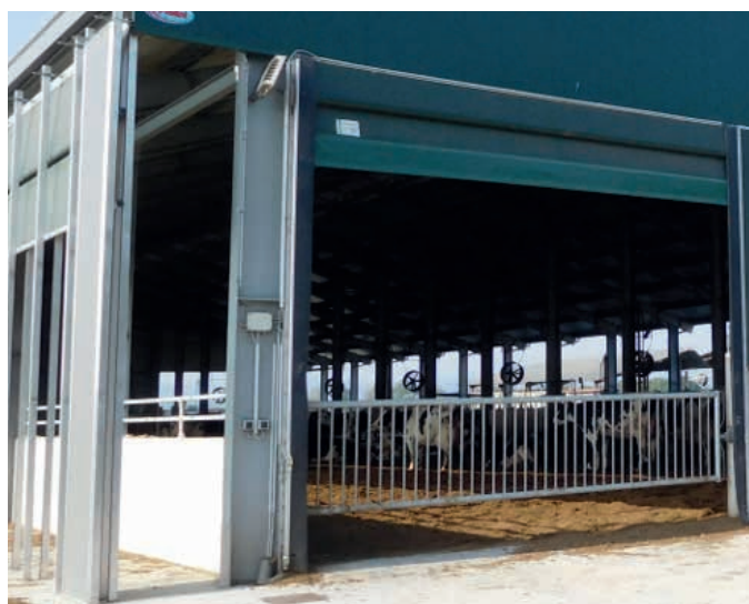
Photo 6. Brise-vent déporté (Crédit : photo BTPL)
